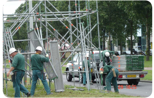
Steigermonteurs aan het werk (tillen)
