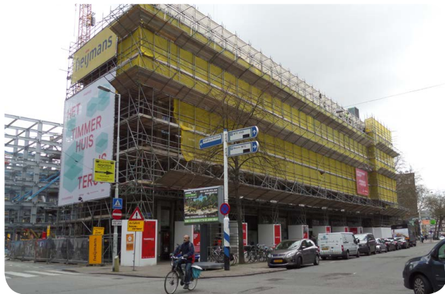
Steiger in gebruik
